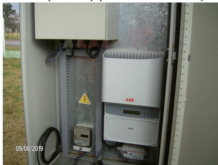
Figura 5 – Gabinete regulador e Inversor del sistema Wintec, y medidor inteligente de salida.
