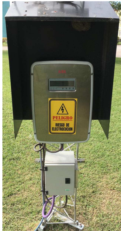
Figura 3 – Base de equipo Eolux e Inversor a Red
