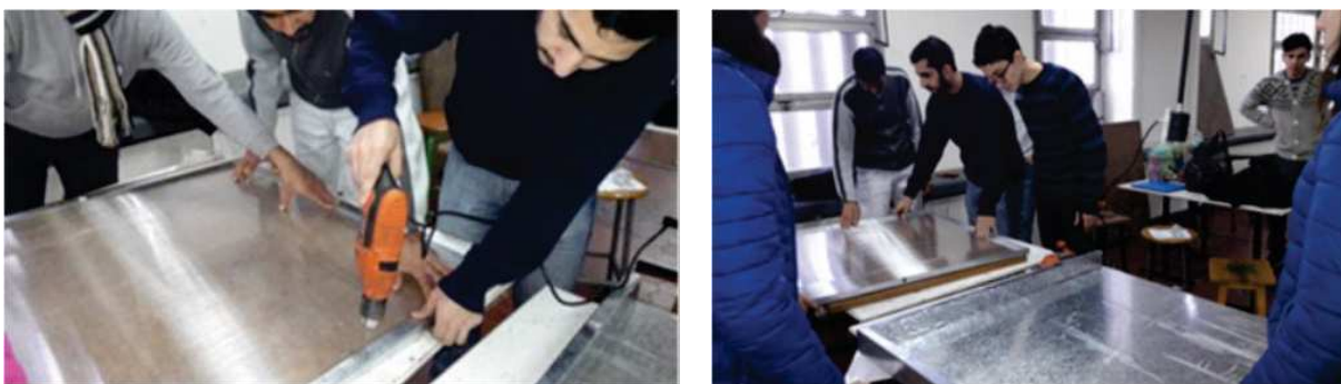
Figura 5: Alumnos de la FAU durante la construcción del calentador solar de agua.
