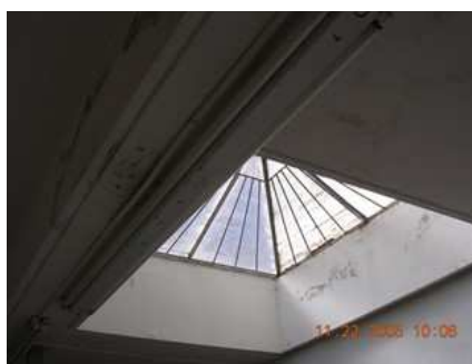
Foto 4.- Lucernario de la sala de lavado.
