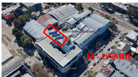
Figura 1: Ubicación de paneles FV en el edificio central FI-UNMDP.
