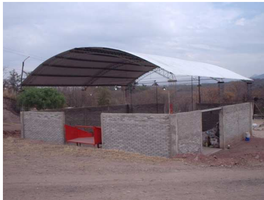
Fig. 6. Prototipo con ladrillos de PET en Unquillo.
