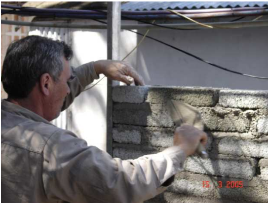
Fig. 5. Montaje de una mampostería.
